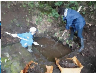
排水溝の泥上げ
